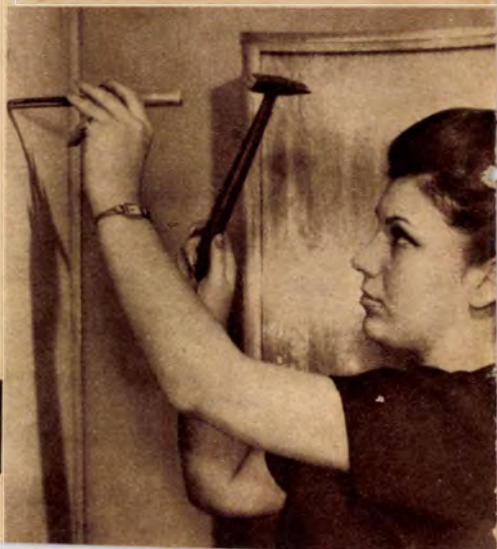
Kiseb tárgyak felfüggesztéséhez a tiplibe különféle menetes csavarok is behajthatók
